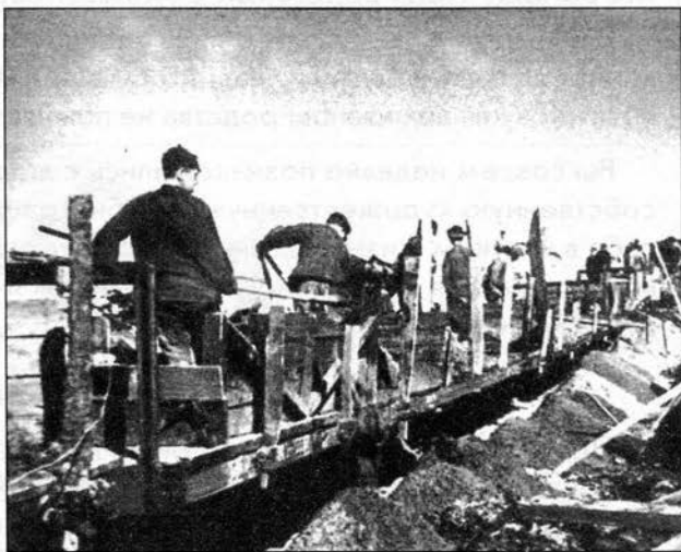
Рытье заключенными котлована под фундамент ТЭЦ. 1942
